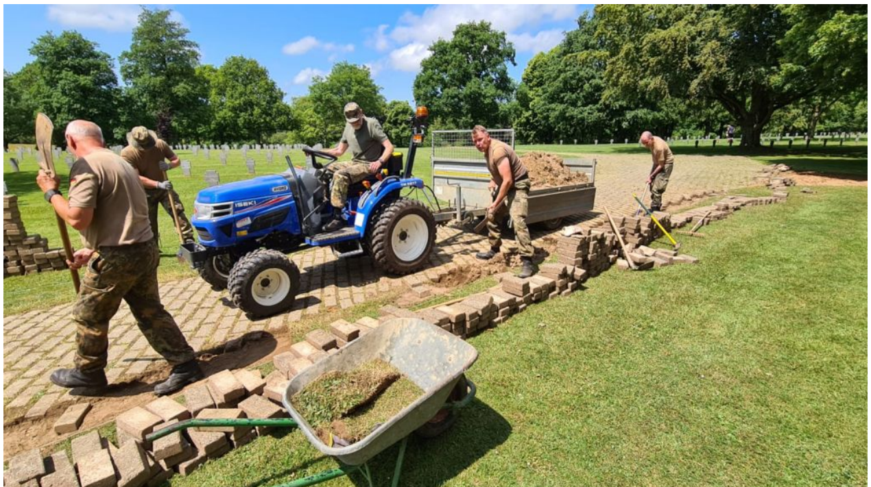
Wegeverbreiterung am Eingangsbereich des Friedhofes Orglandes
